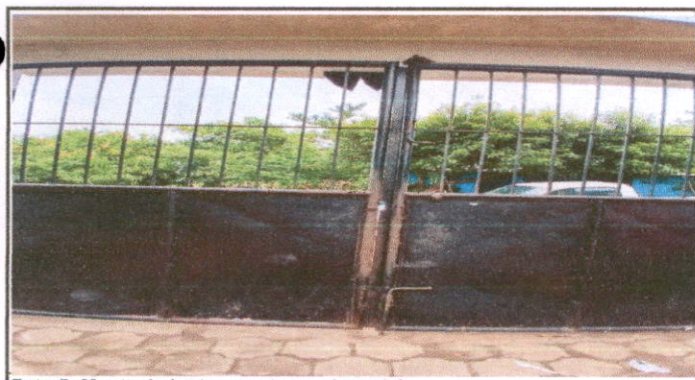
Foto 5: Mantenimiento a portones de metal.
