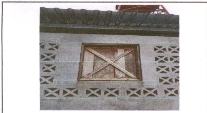
Foto 3: Sustitución de ventanas de madera por metal
