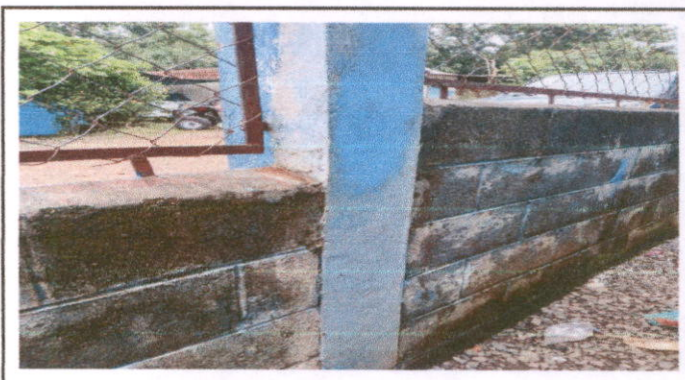
Foto 4: Pintura en muros exteriores e interiores
